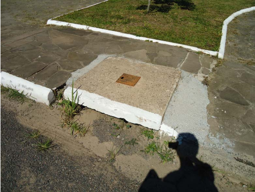
FOTO 11- BOCA DE LOBO EXISTENTE NA AV. HERCULANO LOPES (foto: roberta s. cechín)
